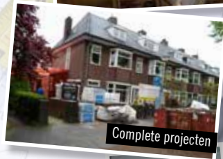
Dakkapel maken + plaatsen
